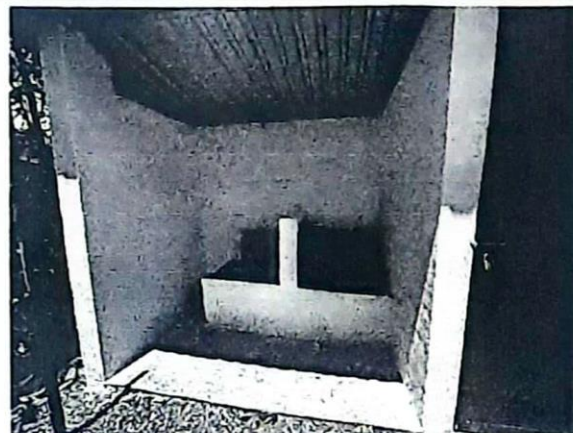
Foto 2: Mejoramiento y continuación de construcción con block.
